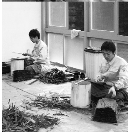
あて台作り・檜皮葺の材料整形
