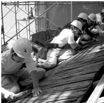
檜皮葺現場実習
