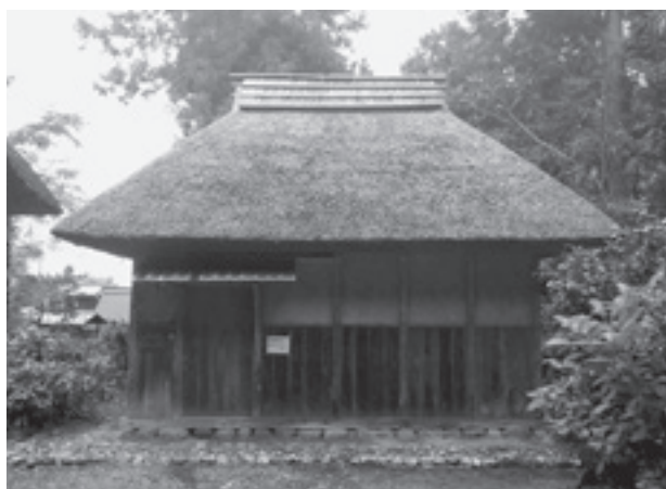
旧武石家住宅 味噌蔵 完成写真
