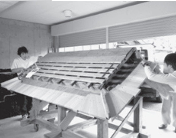
模型葺き実習 (京都市文化財建造物保存技術研修センター)
