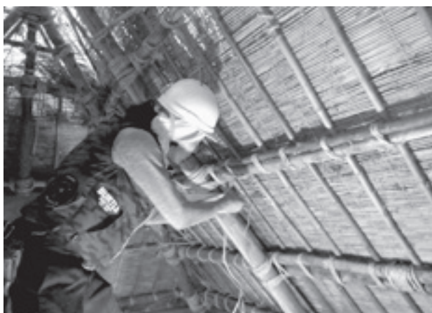
屋根裏側にて藁縄の縛り付け
