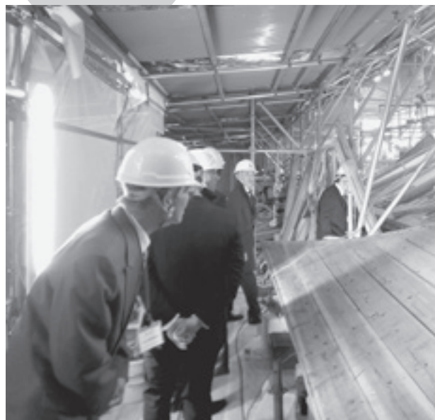
修理現場の見学をする参加者
