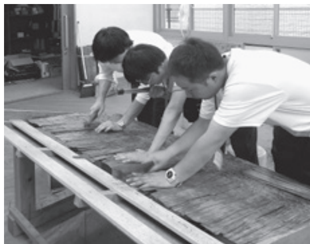
模型屋根葺き実習
