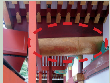
唐金(青銅)に金箔を施した金銅製の雨樋
