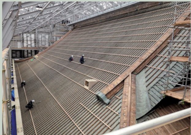
根本中堂の大屋根「瓦棒銅板」の解体作業
