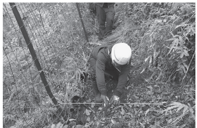
フェンス補習作業
