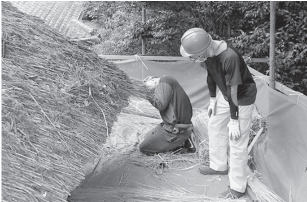
指導員による軒下の補修指導
