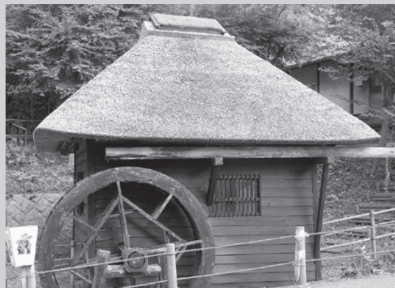
葺き替え後 みちのく民俗村 水車小屋
