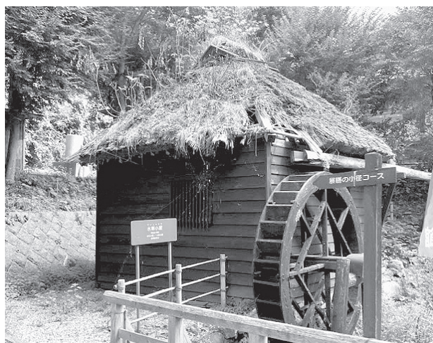
葺き替え前 みちのく民俗村 水車小屋
