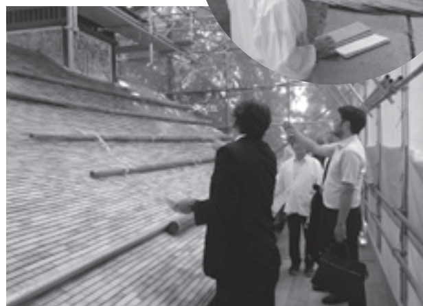
葺き上がった屋根の見学
