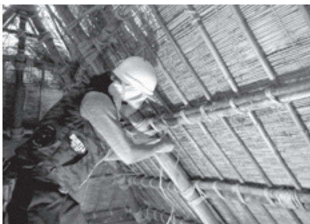
屋根裏側にて藁縄の縛り付け
