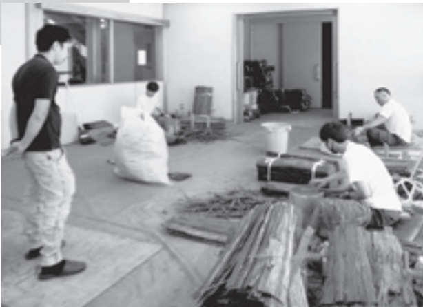
檜皮材料整形 (京都市文化財建造物保存技術研修センター)
