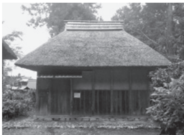
旧武石家住宅 味噌蔵 完成写真
