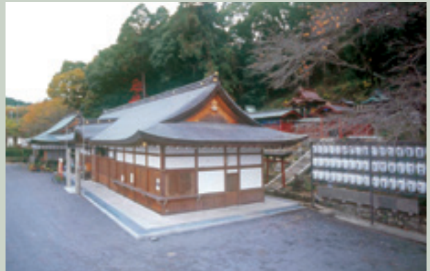
桁行十二間、銅板葺平入母屋造の拝殿
