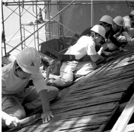
檜皮葺現場実習
