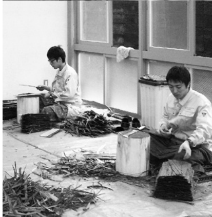
あて台作り・檜皮葺の材料整形
