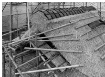
⑤ケラバ施工
