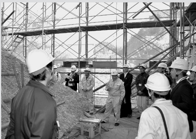
建長寺 鐘楼 茅葺研修現場見学
