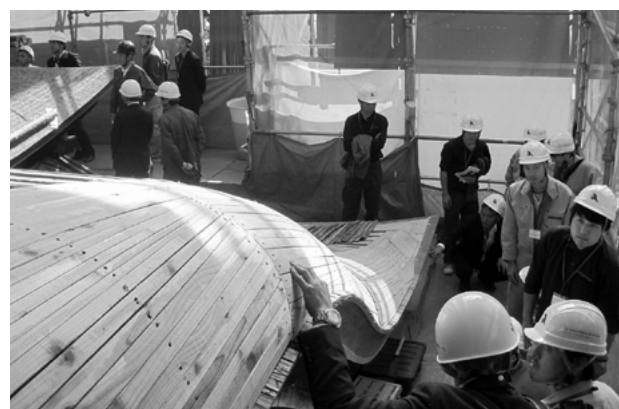
修理現場見学
