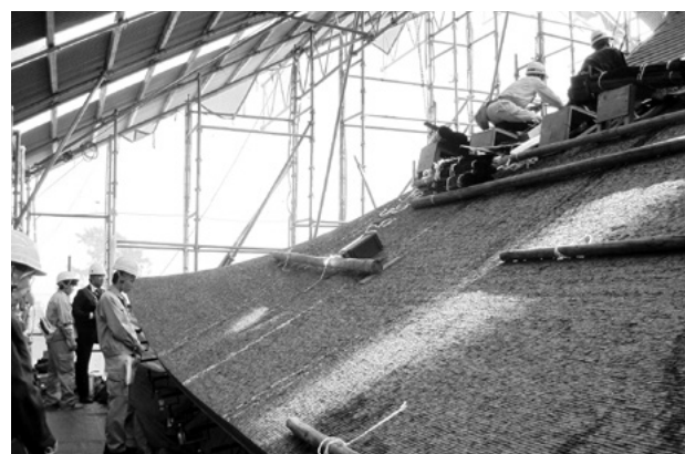
修理現場見学
