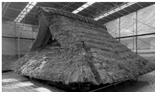
①足場を組んだ施工前の様子
