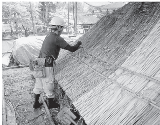
鉾竹の取付け
